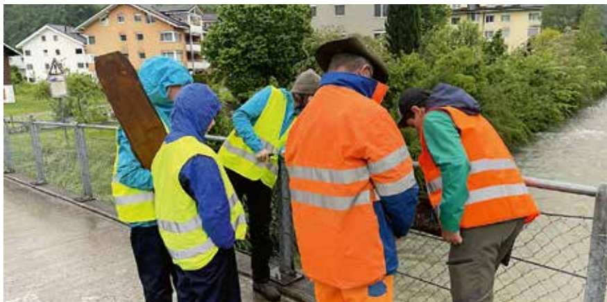
Die Einsatzgruppe entfernt die alte, marode Tafel und ersetzt sie durch die hochgehaltene neue Bachtafel an der Dreiwässerkanalbrücke.
