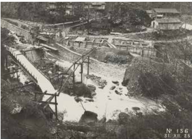
Wasserfassung im Kl. Melchtal, links die Umleitung des Wassers, im Hintergrund mehrere Baracken. (Foto: Staatsarchiv Obwalden)
