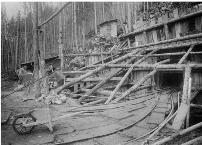
Baustelle beim Stollenportal. (Foto: Staatsarchiv Obwalden)
