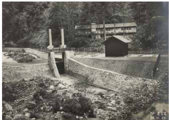
Die fertige Wasserfassungs-Anlage im Kl. Melchtal am 16. Juni 1926. (Foto: Staatsarchiv Obwalden)
