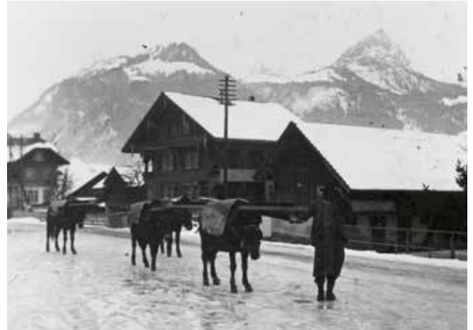
Schwer beladen startet eine Maultierkolonne auf den Weg zur Baustelle ins Kl. Melchtal.
