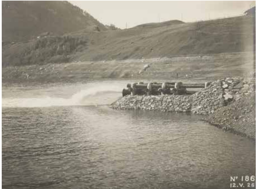
Ein kräftiger Wasserstrahl ergiesst sich aus dem Einlaufwerk bei Kaiserstuhl in den Lungernersee mit 500 l pro Sekunde. Bei 3'000 l pro Sekunde war der Wasserstrahl bedeutend länger. (Foto: Staatsarchiv Obwalden)
