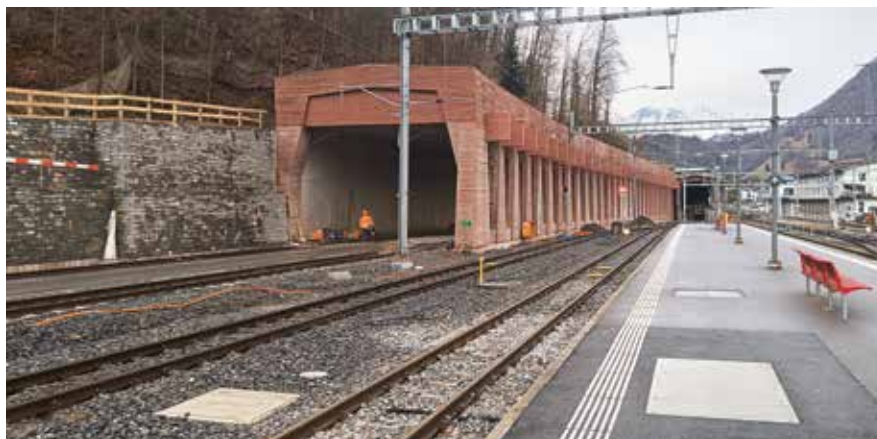
Galerie mit vorgelagerter Trockenmauer, 12. Februar 2026
