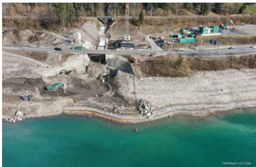
Der Fokus im Winter 2025/26 lag auf dem Bereich Steinlaur. Das Gerinne wurde vergrössert, im Lungenersee ein Auffangraum für Naturereignisse ausgehoben und die Widerlager für die neue Brücke der N8 oberhalb der Brünigstrasse vorbereitet. (Foto: TERRAplan, Februar 2026)
