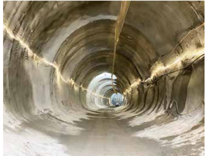
Abgeschlossener Südvortrieb in der Lockergesteinsstrecke. (Foto: Amberg Engineering AG, Februar 2026)
