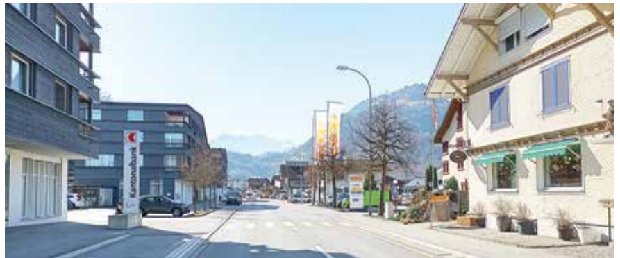
Mit den Neubauten von Gemeindehaus, OKB und Zentralbahn wurde eine erste Etappe der Zentrumsentwicklung realisiert. Dies soll nun weitergeführt werden. (Foto: Gemeinde Giswil)
