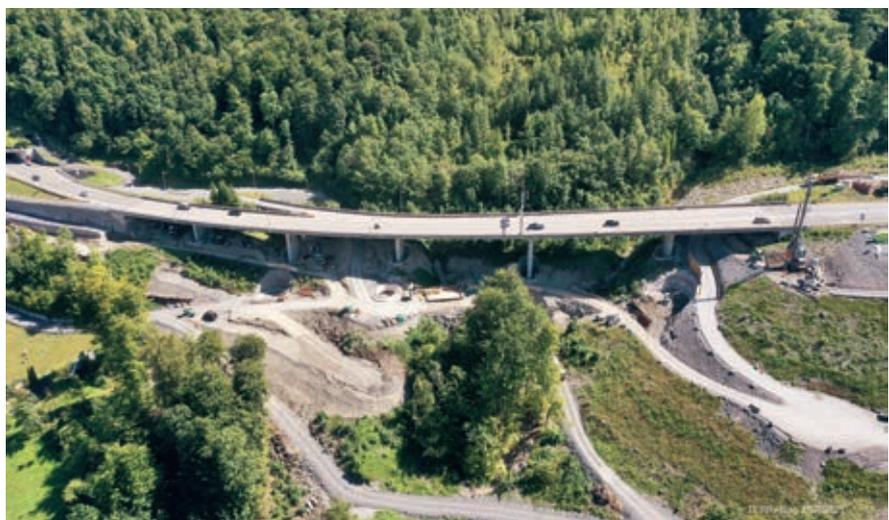
Abbildung 3: Bestehende Buochholzbrücke. Vorbereitung der fünf neuen Schachtfundamente für die zweite Buochholzbrücke. (TERRAplan)
