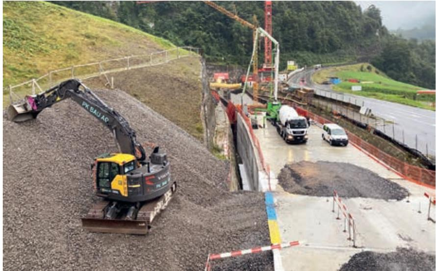
Abbildung 1: Hinterfüllung des Tagbautunnels mit Ausbruchmaterial im Norden. (Amberg Engineering AG)
