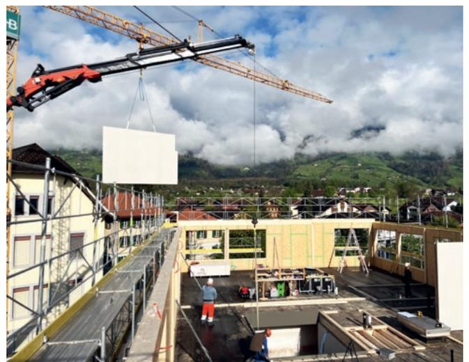
*Mit dem Lastwagen wird die Treppe vom Obergeschoss in das Dachgeschoss versetzt und mit dem Baukran werden die Holzelemente montiert*
