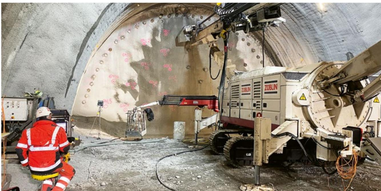
Erstellung Jettingsäulen zur Sicherung im Lockergestein (Amberg Engineering AG)
