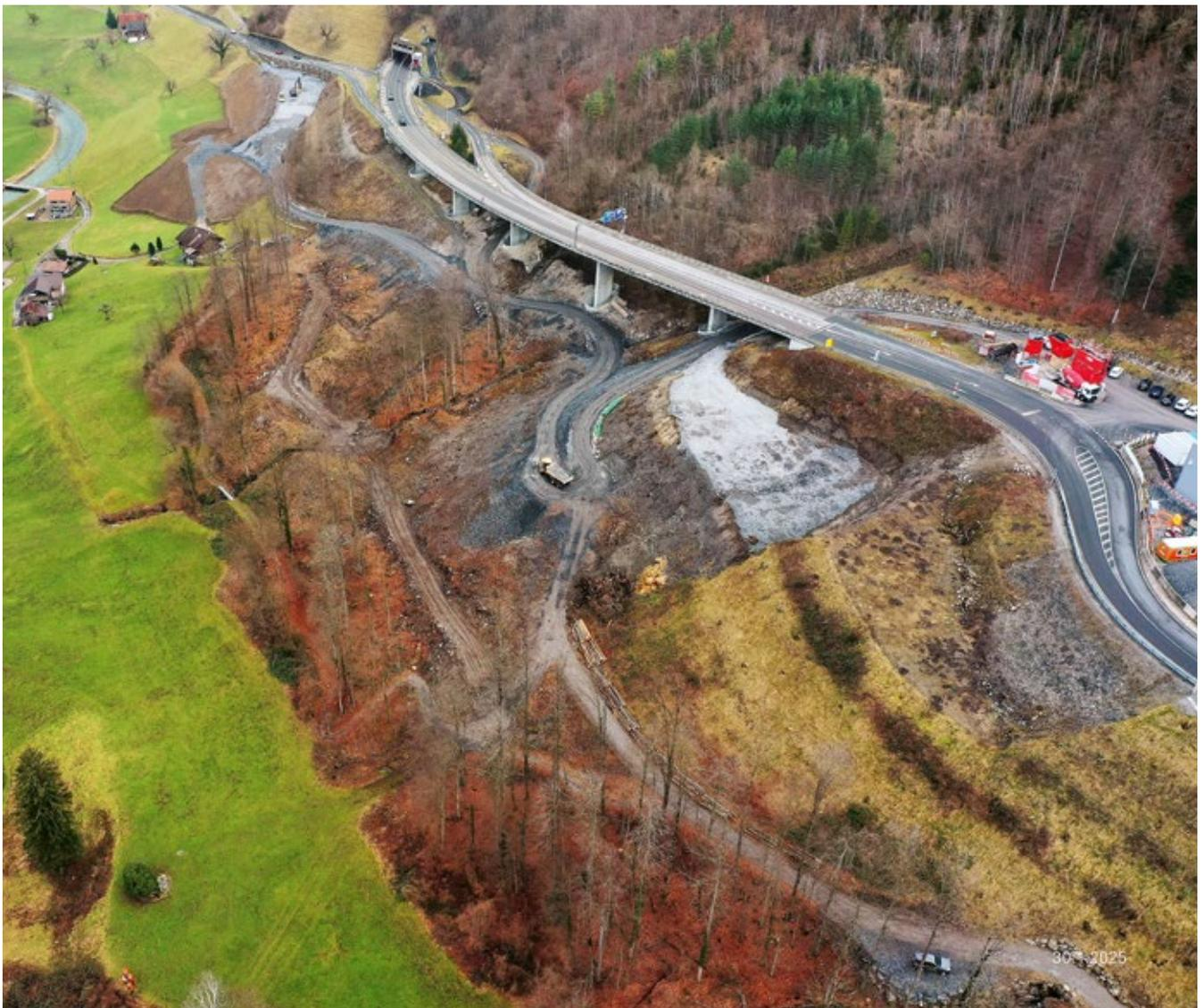
Schüttung von Tunnelausbruch für die beiden Widerlager der neuen Kantonsstrassenbrücke Buochholz (TERRAplan)
