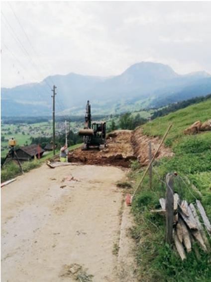
*Neuerstellung Strassenfundation infolge Durchnässung und Rutschung auf der ganzen Strassenbreite. Zusätzlich wurde bei diesem Bereich der talseitige Strassenrand durch eine Bankettverstärkung mit einem Böschungskorb (Sytec Terramur) gesichert.*
