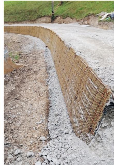
*Bankettverstärkung mit einem Böschungskorb (Sytec Terramur) im Bereich Summerweid.*
