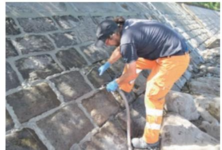
Mit einer Mörtelpumpe werden die Fugen mit neuem Fugenmaterial ausgefüllt.
