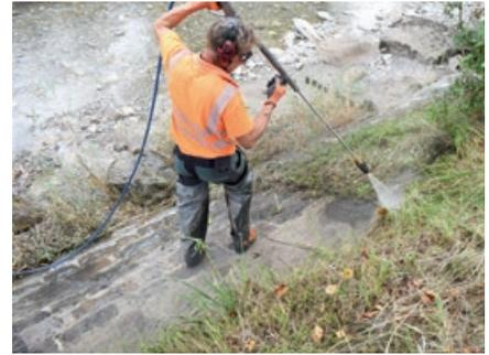
Mit Hochdruck werden die teilweise überwachsenen Fugen gereinigt.
