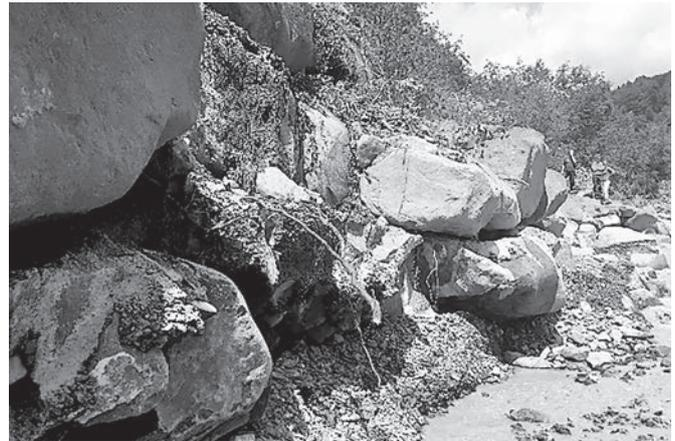
Bei zahlreichen Betonsperren in der Mettenlauri und im Steinibach sind Teile der Steinabdeckungen der Sperren weggerissen worden, sodass die Sperren nun stark der Erosion durch Geschiebe ausgesetzt sind. An der Lauri und am Steinibach sind zudem mehrere Seitenleitwerke zwischen den Sperren unterspült und stellenweise Blöcke herausgerissen worden.
