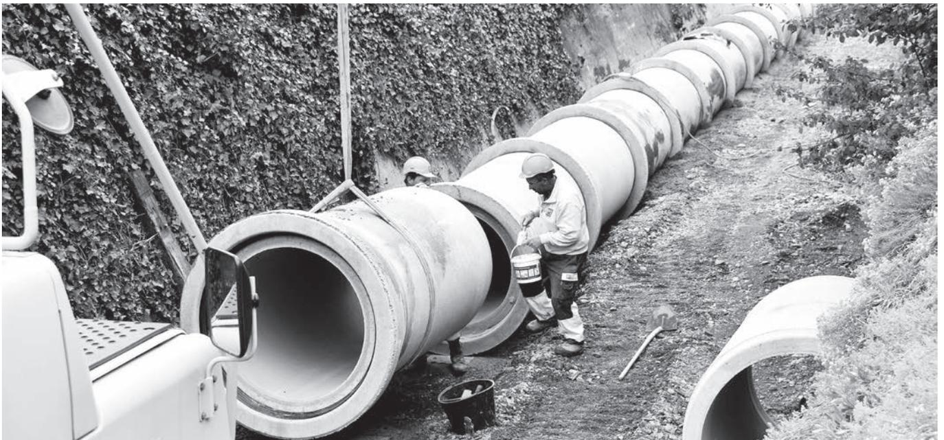
Die Firma PK Bau Giswil verlegte die Rohrleitungen für das Meteorwasser
