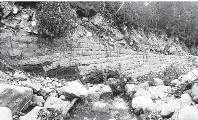
In der Lauri wurde ein Seitenleitwerk unterspült, welches die Basis für den Hochwasserschutzdamm Zimmerplatz bildet.
