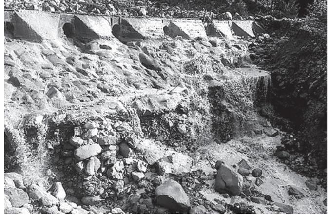
Mehrere Brücken und Furten wurden durch Tiefenerosion, Kolke oder unterspülte Brückenwiderlager beschädigt. Diese Brücken und Furten sind in ihrer Stabilität gefährdet.
