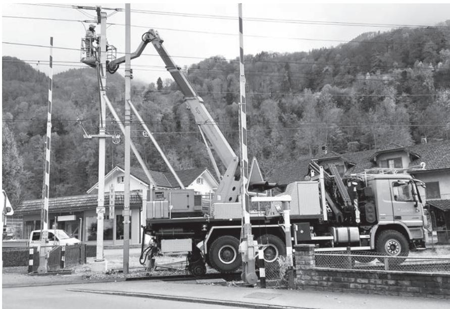
Mit einem schienentauglichen Spezialfahrzeug wurden die alten Fahrleitungen ersetzt.
